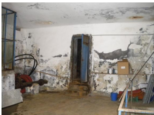
F.10 - Serbatoio vecchio - piano terra ingresso alle vasche
