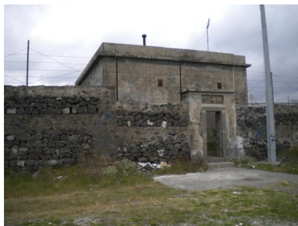
F.8 Esterno del serbatoio vecchio
