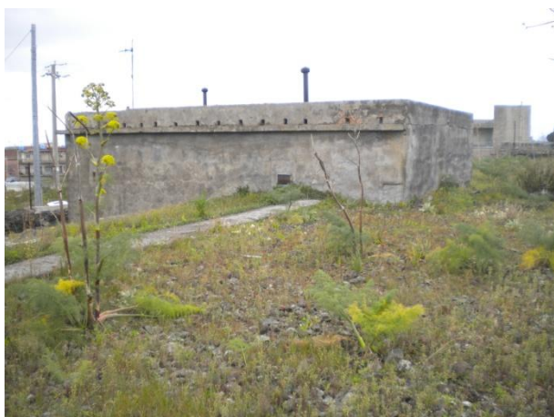
F.7 Esterno del serbatoio vecchio
